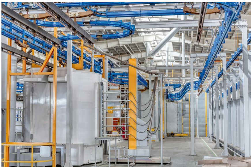
Bei der chemischen Vorbehandlung wird zwischen Vorbehandlungslinien mit reinem Aluminiumdurchsatz, mit gemischtem Durchsatz oder Teilen in Mischbauweise unterschieden.
